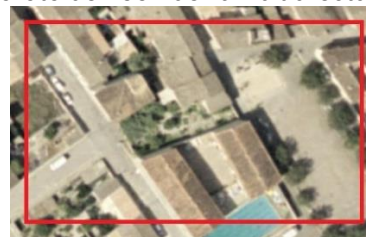
Retall ortofoto de 2002 de l'àmbit afectat.
